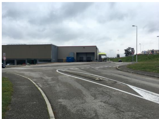
6 – Vue du carrefour des rues de Sans-Soucis et Pourrat en amont de l'accès à la parcelle AB122
