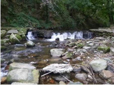
Seuil de l'Allier avant travaux
