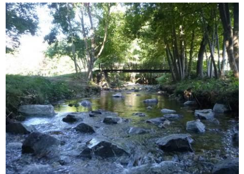
Pose de blocs en amont de l'ancien seuil
