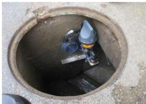
La collectivité surveille quotidiennement 13 déversoirs d'orage. Les appareils installés dans ces ouvrages permettent de mesurer le temps de déversement au milieu naturel, ainsi que les débits d'eaux usées.
